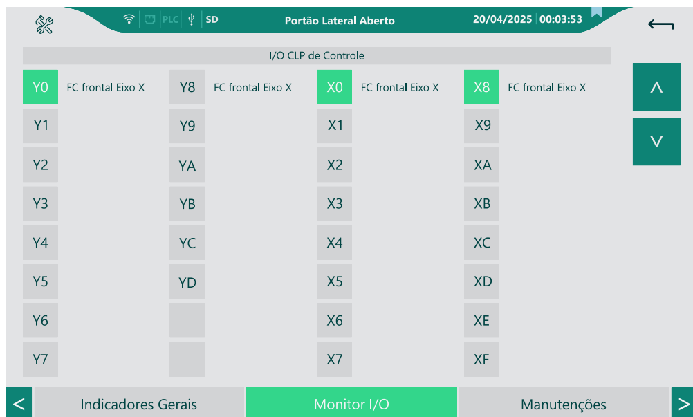
Manutenção - Monitor IO
